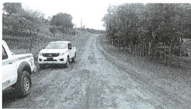
Fotografía No. 11: Conformación de calzada, alineamiento de la Circunvalación Pesé.
