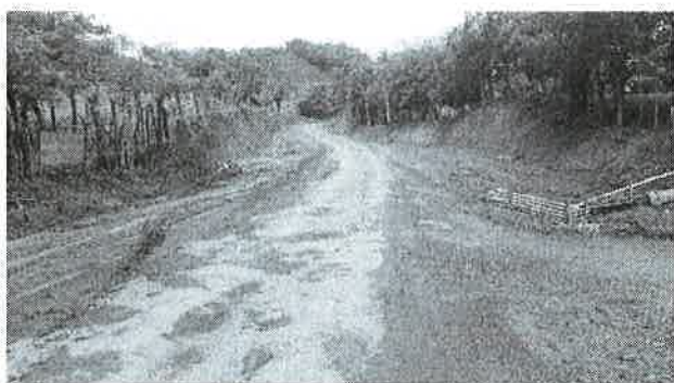
Fotografía No. 12: Conformación de calzada, alineamiento de la Circunvalación Pesé.
