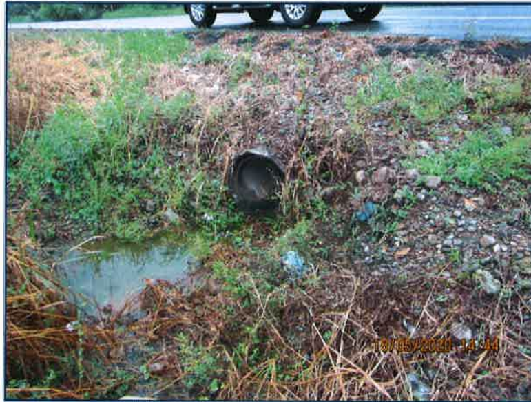
Foto 12. Tubería de drenaje pluvial en la cual descarga hacia la Quebrada Sin Nombre. Fuente: JACUM, mayo de 2020.
