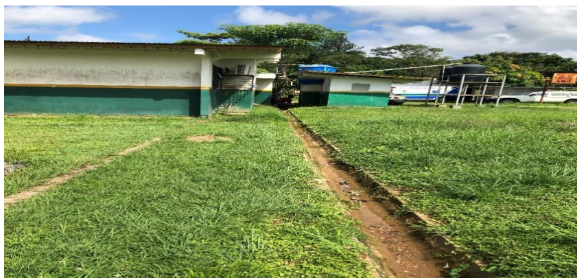
Ilustración 10. Cuneta para canalización de agua pluvial
