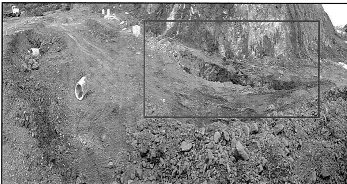
(Fig. 7) Se observó durante la inspección fosas las cuales según el Ing. a cargo es donde se ubicarán los sótanos y el material extraído es el que se ha utilizado en la construcción de la infraestructura vial.
