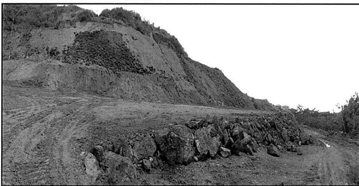
(Fig. 4) Se observa que la adecuación de la infraestructura vial que se construye cuenta con roca, la cual fue extraída del sitio, según información suministrada por Ing. a cargo.
