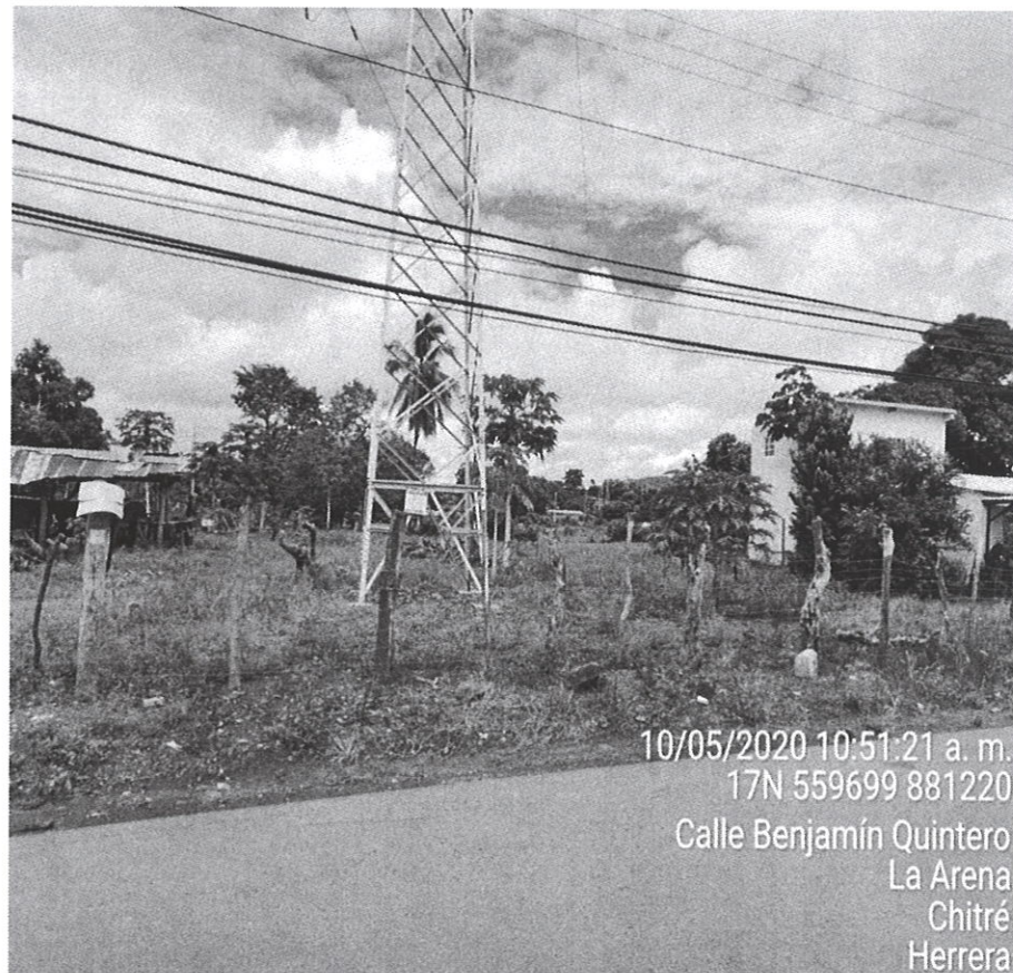
Fig. N° 4 Se observa torre de la línea de alta tensión existente, en este sector se soterrara 1500 metros aproximadamente de la nueva línea, la misma pasara por terrenos privados, sin embargo existe servidumbre según resuelto N°666 de 17 de julio de 1975, del Ministerio de Obras Públicas. (MOP).
