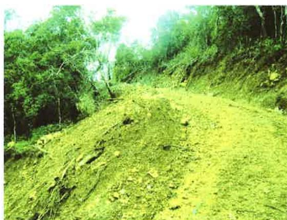
**Foto. 4.** Corte y movimiento de tierra en el camino de acceso del lado del estribo 1.
