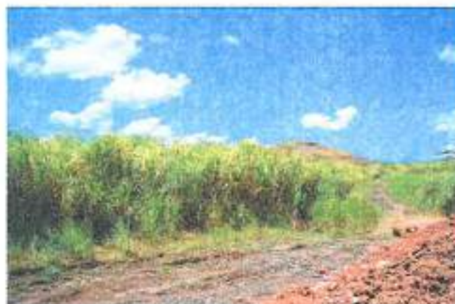
Foto 2 Conformación de algunos de los caminos de tierra con cubierta de capa base o tosca.
