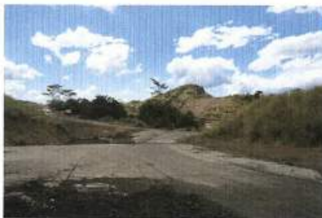
Foto 10 Vista de la conformación de la carretera que se levantó para el acceso.
