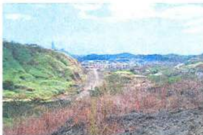
Foto 7. Vista parcial de los trabajos del proyecto que se trabaja dentro "Diseño y Construcción de Calle vehicular sistema pluvial y acueducto – Condado Point"
