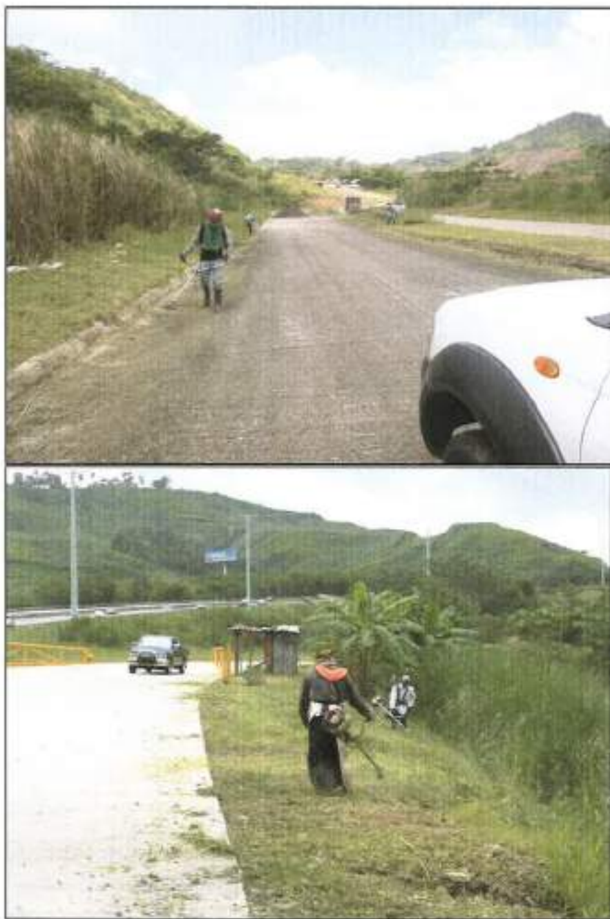
Imágenes #3 y 4: Limpieza periódica por parte de la cuadrilla de Empresas E Inversiones Arango, S.A., de las áreas continuas a la calle construida por Pycsa para controlar los herbazales.
