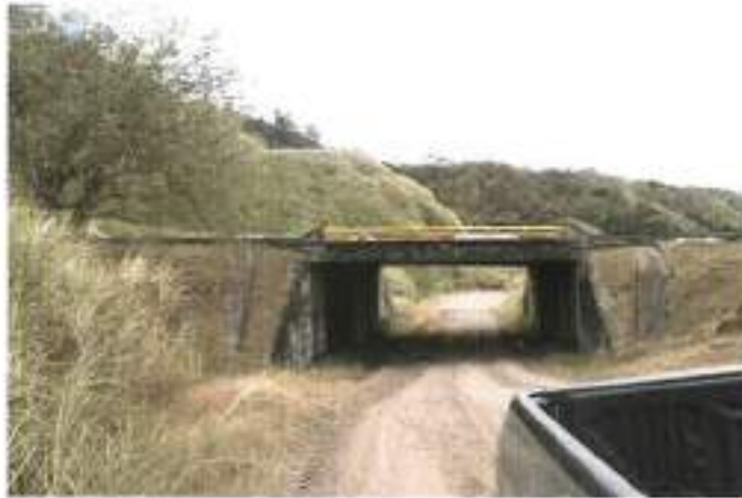
Foto 11. Vista del paso debajo del Corredor Norte y que da acceso al otro sector del proyecto.
