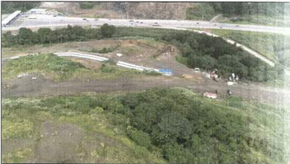
Imagen #6. Vista panorámica donde se aprecia el proyecto "Diseño y Construcción de Calle vehicular, sistema pluvial y acueducto – Condado Point"
