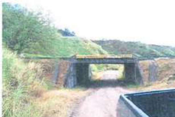
Foto 10. Vista del paso debajo del Corredor Norte y que da acceso al otro sector del proyecto.
