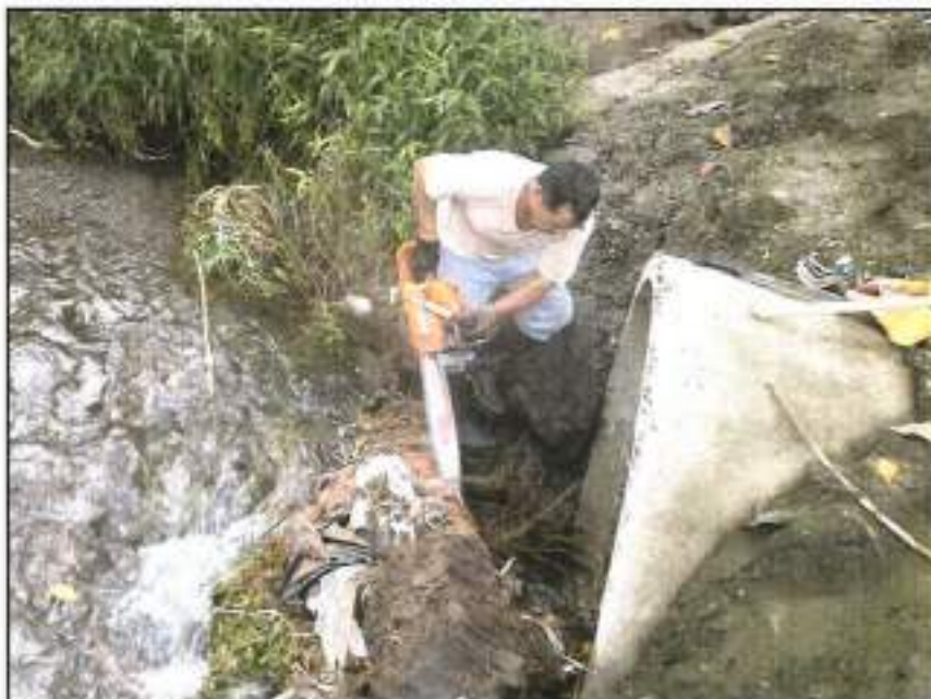
Imagen #2: Limpieza periódica por parte de la cuadrilla de Empresas E Inversiones Arango, S.A., de los drenajes pluviales y alrededores del vado en el cual se concentra la basura proveniente de aguas arriba específicamente de los poblados de Chivo Chivo
