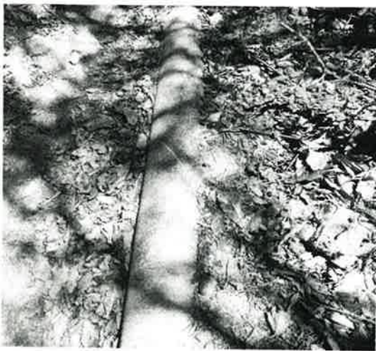
Fig. 3: Tubería existente que conduce el agua de la toma existente a el tanque de almacenamiento.
