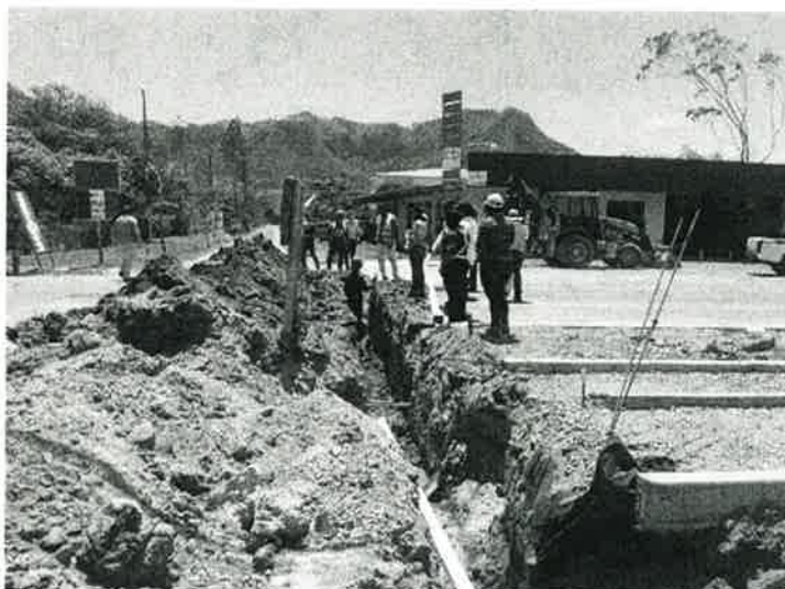
Fig. 14: Se puede observar parte de los trabajos que está realizando la empresa contratista, entre ellos están la instalación de tubería de distribución en la vía principal de El Valle, justo en el área donde se está construyendo actualmente la ciclo vía.
