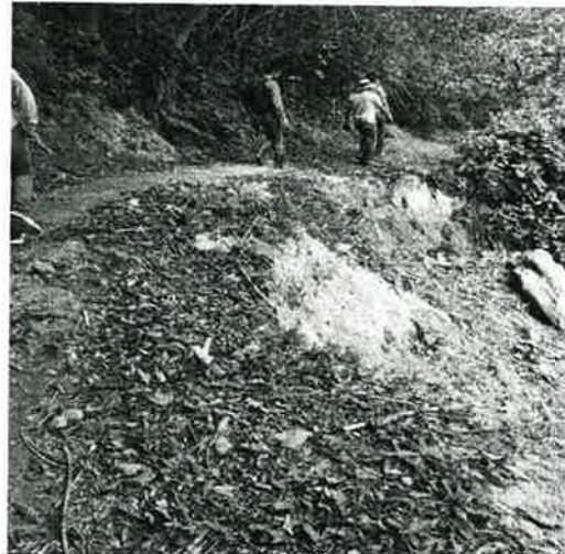
Fig. 2: Uno de los puntos críticos (deslizamientos en uno de los laterales del Río Antón) identificado dentro del camino de acceso para llegar a los sitios de captación.
