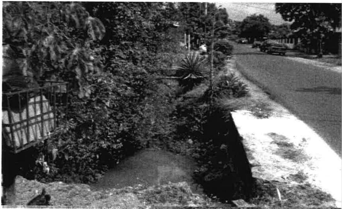
Dos tubos de 0.90 m. de diámetro. Longitud de 12.00 m. Invert 8.29 m. Los tubos están tapados por sedimentos de tierra
