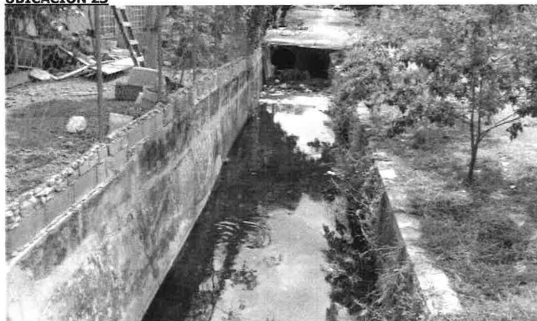
Cabezal Tubo de 1.20 m y Tubo de 0.90 m de diámetro. Invert 5.56. Cabezal con dos vías de desagüe.
