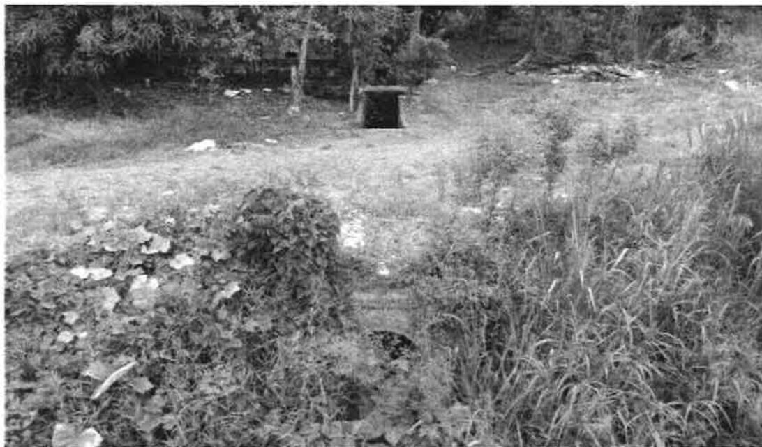
Tubo de Hormigón de 0.90 m. Longitud del tubo de 12.00 m. Invert 12.57 m. El tubo está parcialmente cubierto de tierra.
