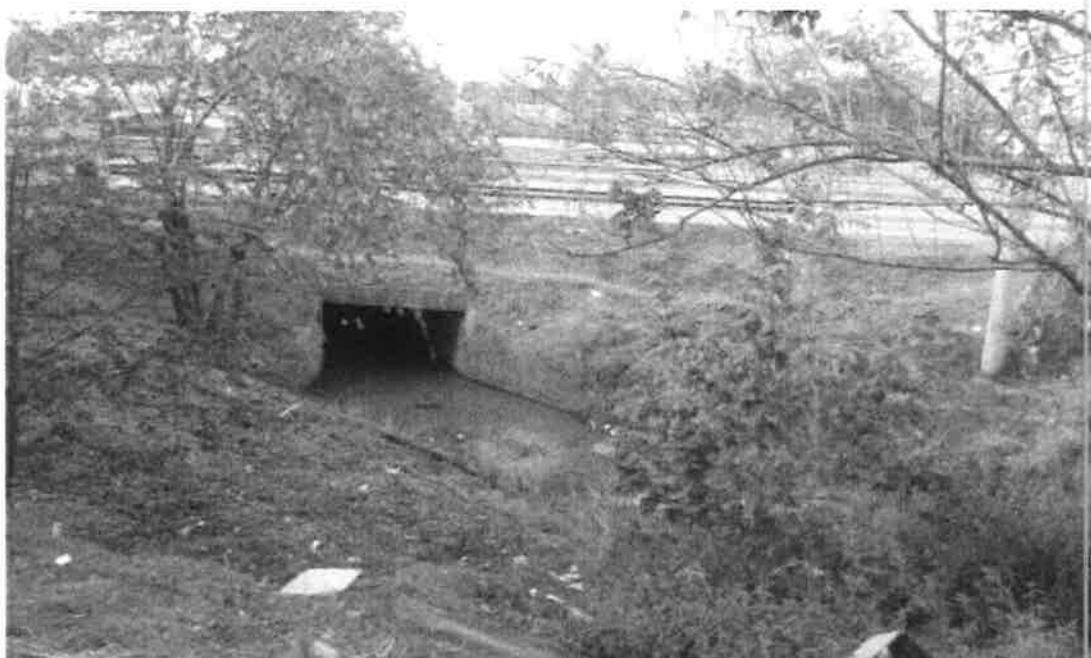
Canal Pluvial ubicado en el relleno a un lado del Corredor Sur. Se encuentra sucio debido al sedimento de tierra erosionada.
