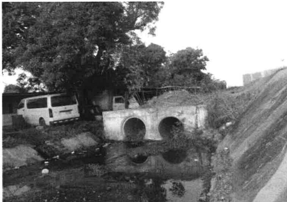
Dos tubos de 0.60 m de diámetro. Tuberías que van desde el canal abierto colindante con Ciudad Radial hasta la Quebrada La Gallinaza
