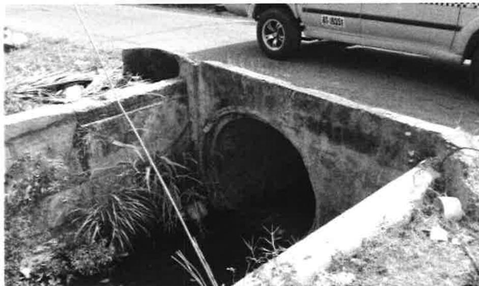
Tubo de 1.20 m. de diámetro. Longitud de 7.00 m. Invert 5.72 m. Tubería debajo de calle de asfalto.
