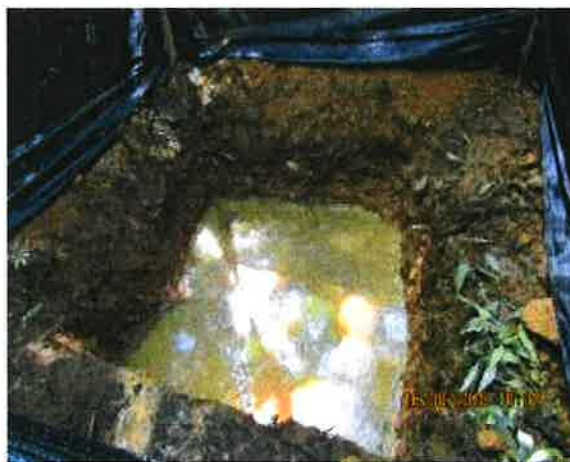
Imagen 3. Ejemplo de conformación de tina o poza de sedimentación
