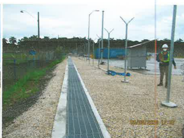
Foto 5. Colocación de cerca perimetral y cajón pluvial
