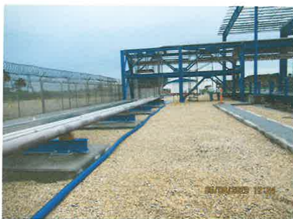
Foto 2 y 3. Se aprecia instalación de tuberías para el traslado trasiego del gas natural licuado, área de bascula puente y bahías de carga. (en construcción)
