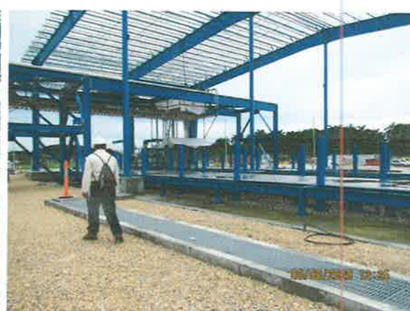
Foto 2 y 3. Se aprecia instalación de tuberías para el traslado trasiego del gas natural licuado, área de bascula puente y bahías de carga. (en construcción)
