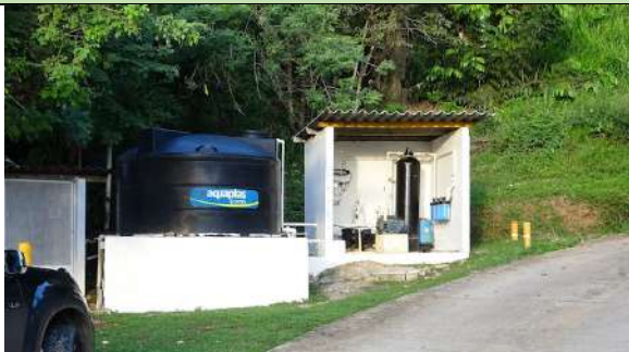
Foto 38) Pozo, sistema de filtrado y tanque primario de almacenamiento
