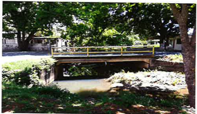
de Veracruz, en este punto se pretende demoler el puente vehicular existente de un carril y en su lugar construir uno de dos carriles, con aceras de ambos lados.
