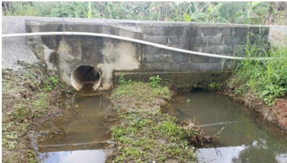
Foto 6. Cruce en camino de acceso lateral al proyecto. Salida de Quebrada Sin Nombre 2Tuberías Ø36" PVC y H.R.
