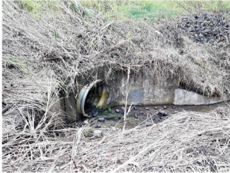
Foto 3. Vista de Salida de Tubo Acero Corrugado Ø42" en canal rectangular de concreto existente.
