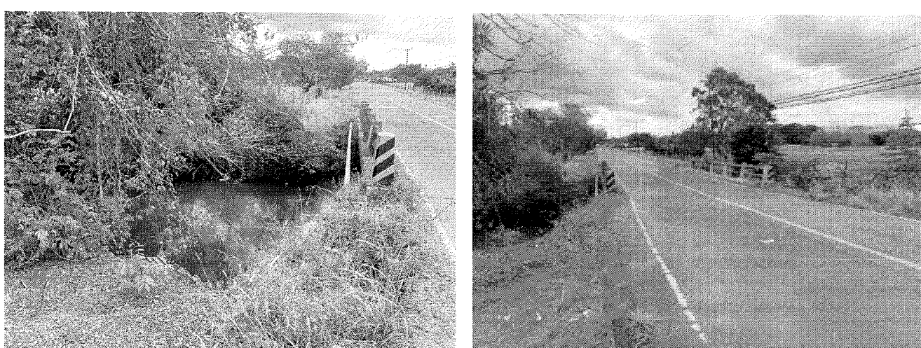
Fig. 1 y 2: Puente sobre la quebrada El Roble, dicha quebrada mantiene vegetación mayormente compuesta por rastrojo y algunos arboles los cuales serán talados para la limpieza del cauce.
