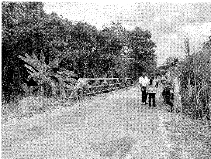
Fig.6: Puente sobre quebrada La Cotaba, el cual quitaran la estructura existente y construirán uno nuevo
