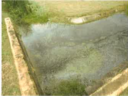
Los canales de agua en el proyecto, con residuos de sustancia aceitosa.
