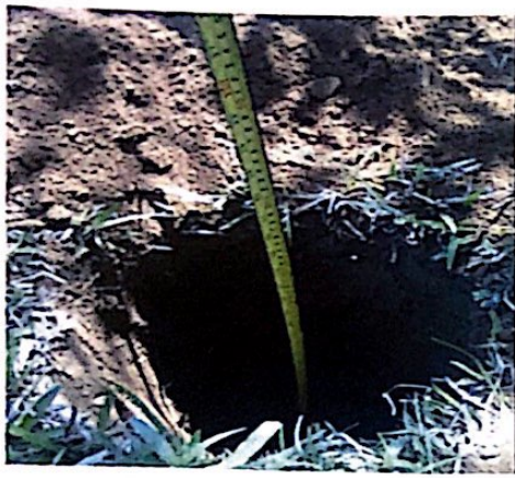
EXCAVACION DE 60CM DE PROFUNDIDAD POR 30CM DE DIAMETRO
