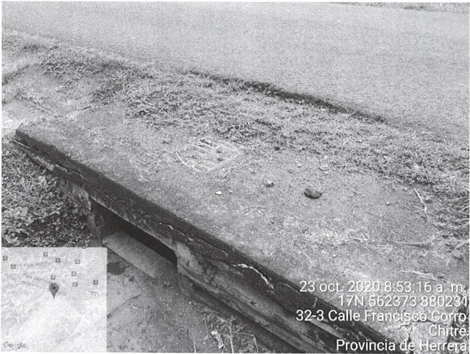
Fig. No. 3: Vista del tragante pluvial que atraviesa de forma soterrada la Calle Francisco Corro, se percibieron olores a aguas residuales (próximo al área del proyecto).
