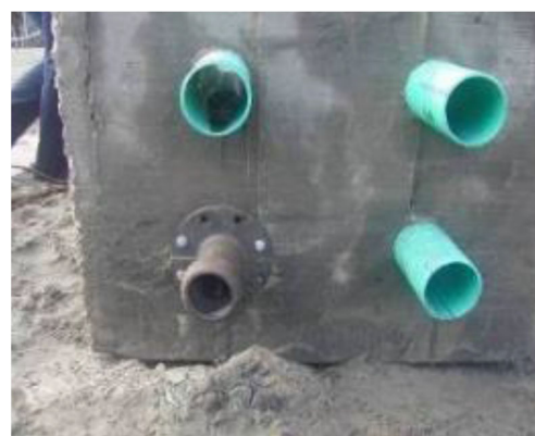
Figura 18: Adaptador de brida típico
