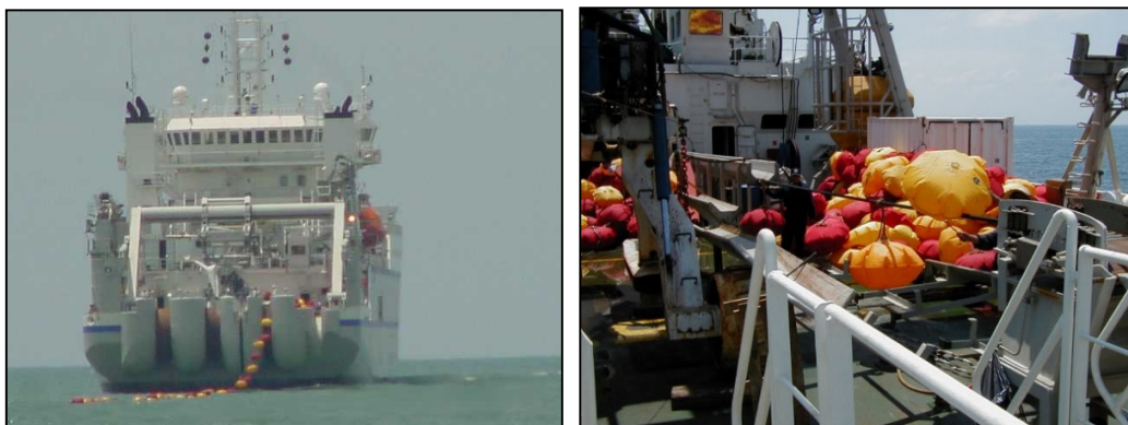
Figura 8: Instalación Marina Atraque Directo de Buque Cablero
