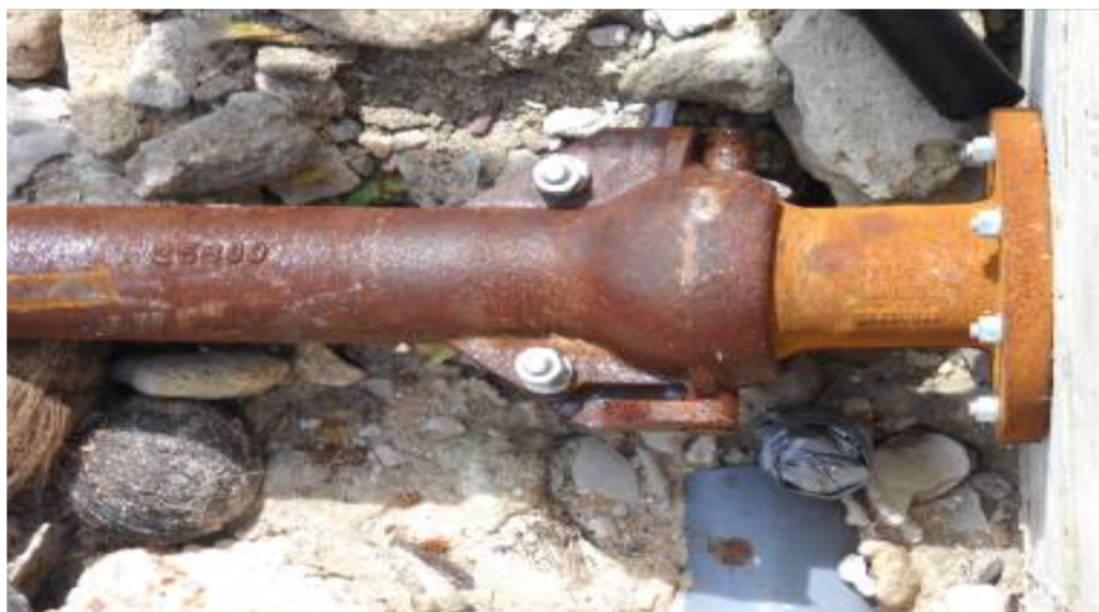
Figura 21: Instalación típica de tubería dividida
