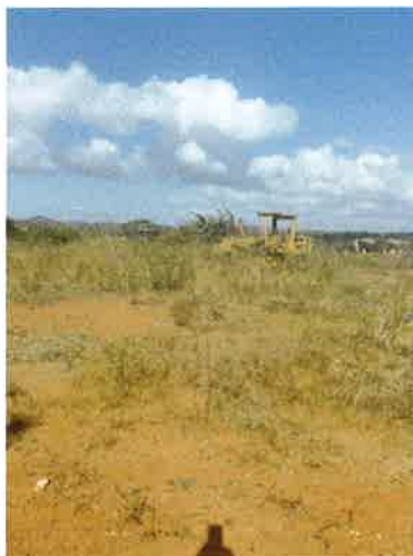
Foto N°15: Vista general. Tramo prospectado.
