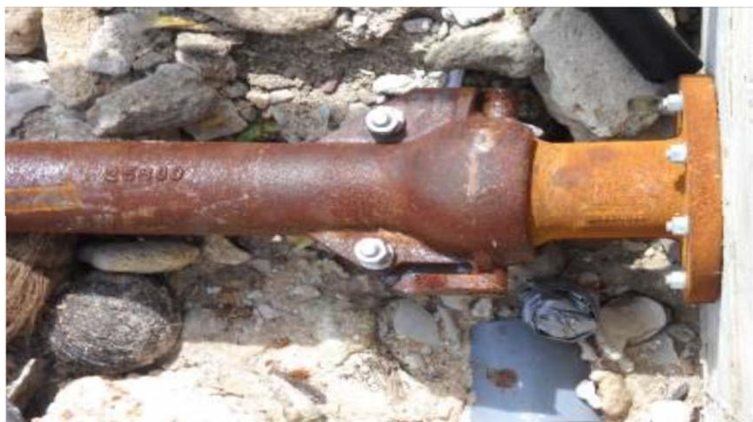
Figura 21: Instalación típica de tubería dividida
