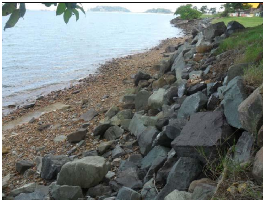
Foto No. 6: Vista de relleno empedrado de la costa en Amador
