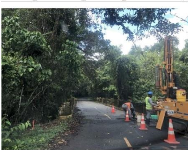
Puente sobre Río Las Lajas, Punto crítico N°2.
