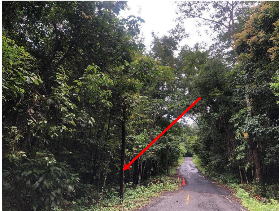
Poste de madera afectado. Punto Crítico N°1 (Estudio Puntos Críticos)
