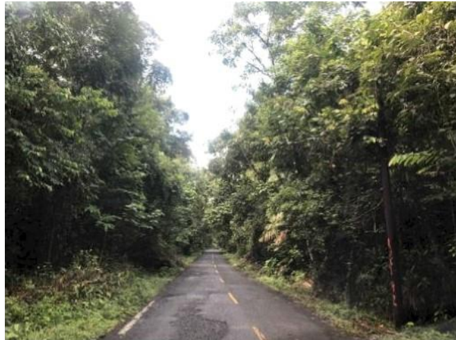
Vista del punto crítico N°1 y poste eléctricos existente en el área.
