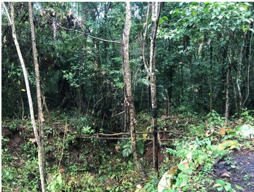
Vista aguas abajo, tubo existente. Punto crítico N°1. (Estudio Puntos Críticos)
