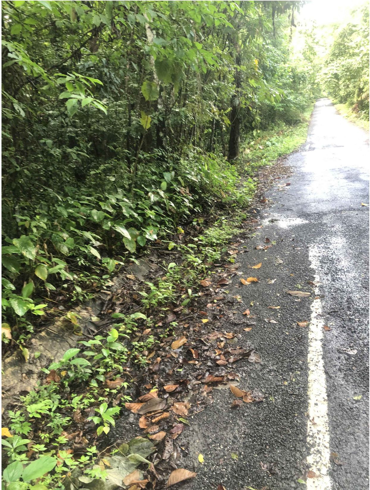
FOTO PC1 - 01. CUNETA AFECTADA A DEMOLER
