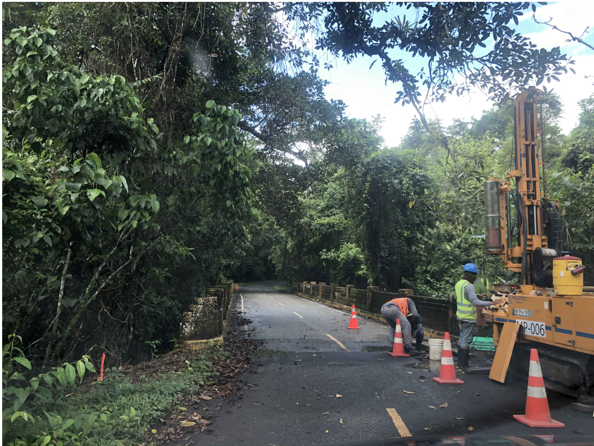
FOTO PC2 - 03. PUENTE SOBRE RÍO LAJAS JUNTO A PUNTO CRÍTICO 2
