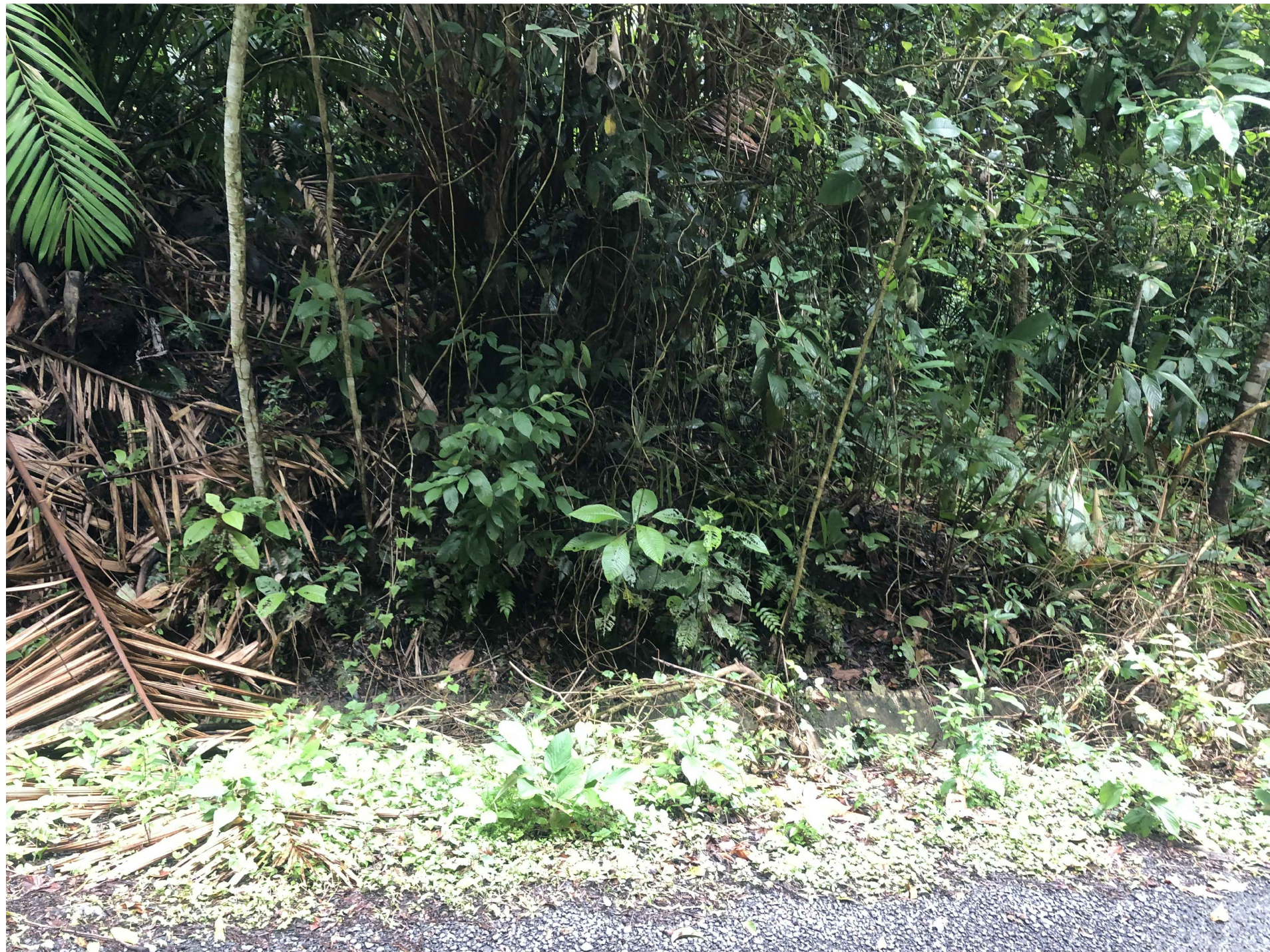
FOTO PC2 - 02. CUNETA TRIANGULAR A DEMOLER
