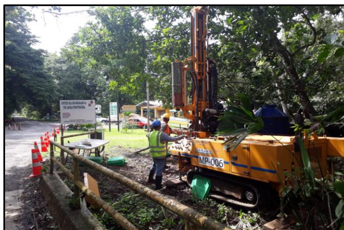
Figura 5. Equipo de perforación utilizado en la ejecución de los sondeos-Puente sobre río Arenal
