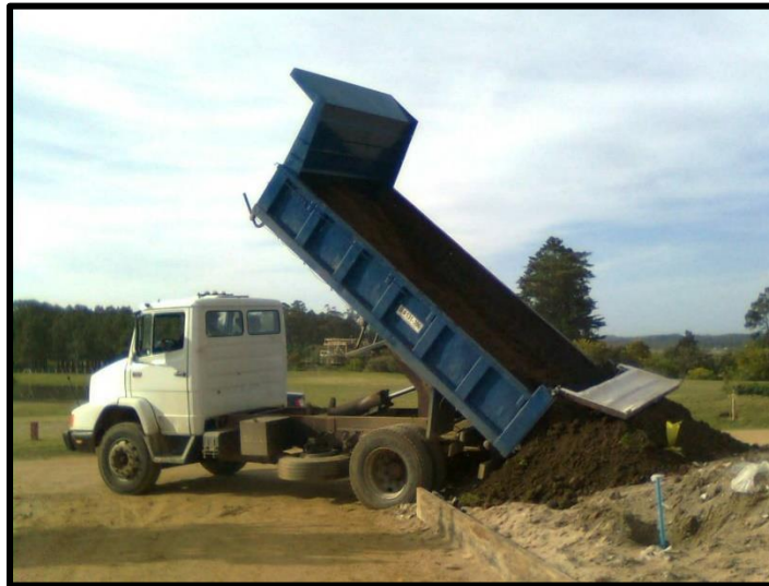
Figura 8. Camión colocando suelo a través de la técnica de volteo directo.
