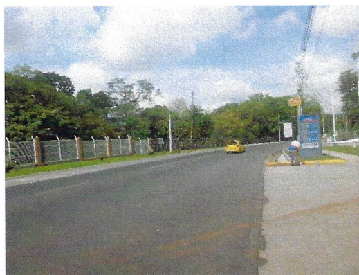
Foto N° 8: Vista general. Tramo prospectado alterado. Cuneta.
