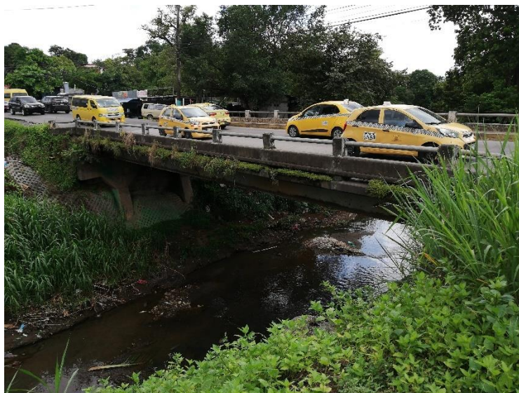
Fotografía 1 Puente existente sobre Río Cabuya, vista hacia aguas abajo
