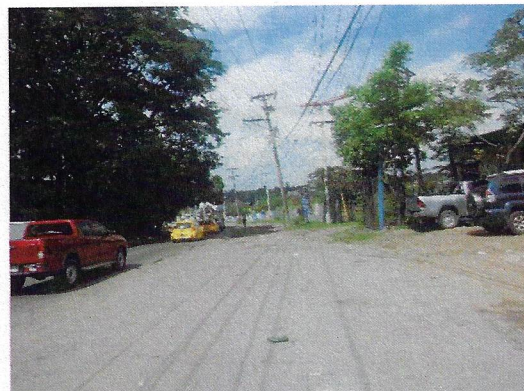
Foto N° 18: Vista general. Tramo prospectado
