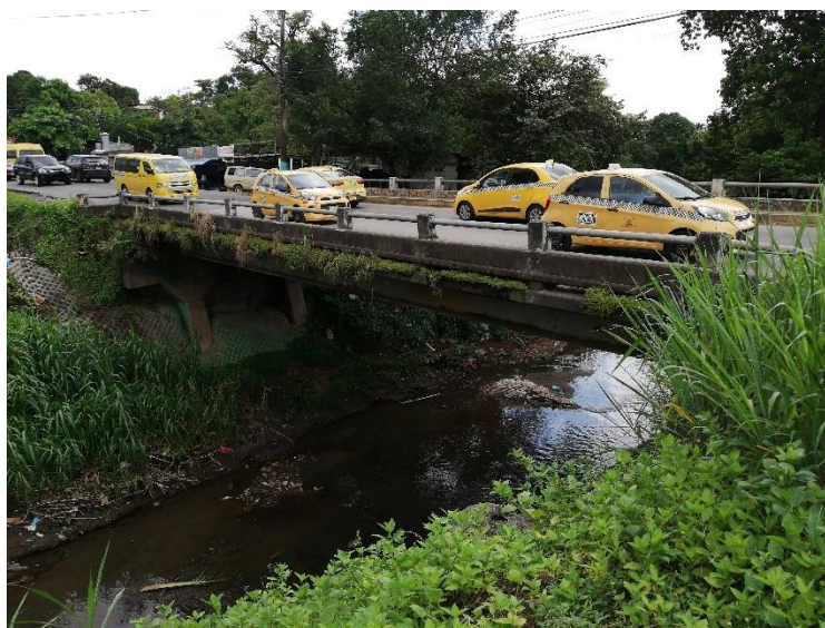
Fotografía 1 Puente existente sobre Río Cabuya, vista hacia aguas abajo
