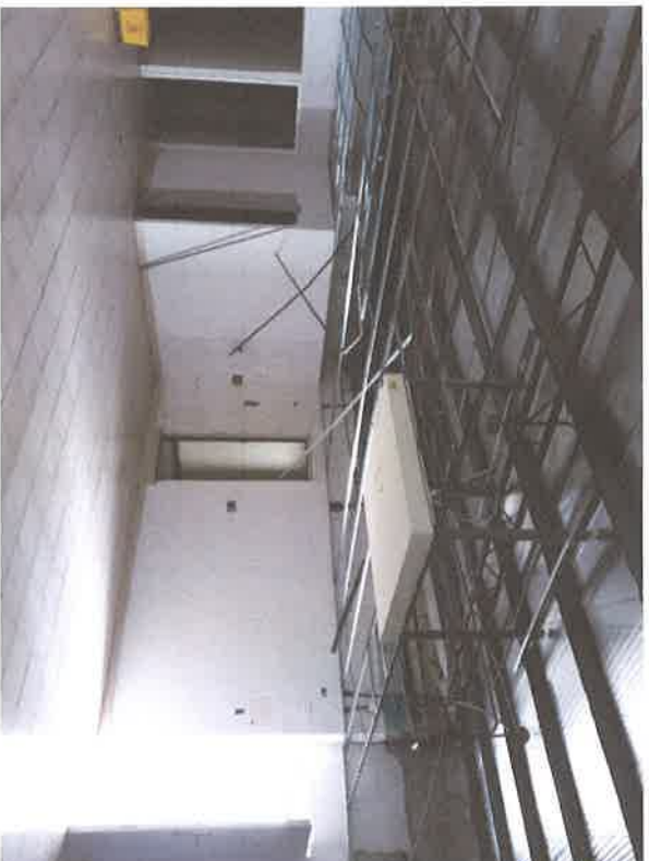
Foto #9 (14-enero-2019): Condición actual interna del anexo posterior discordante que se construyó hacia 1990. Estructura de concreto, techo de láminas zinc, cielo raso suspendido.
