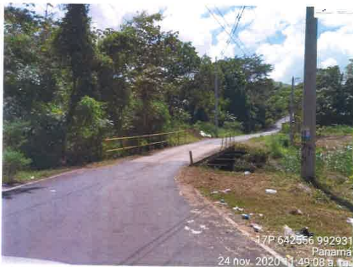
Foto No. 7. Puente de una vía en malas condiciones, por donde transitar el equipo pesado
