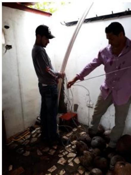
Fig.12- Desinstalación de tubería de bombeo y piezómetro en el pozo PP1
