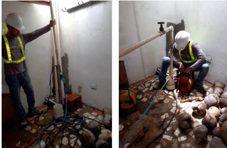
Fig.9 y 10- Instalación del sistema de bombeo, para la posterior aplicación de la prueba de recuperación de niveles de agua subterránea en el pozo PP1.
