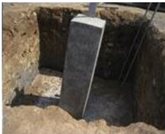
Imagen 8. Área de excavación requerida para la fundación de las Torres
