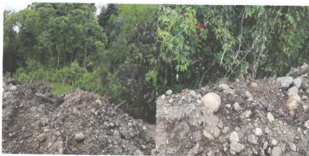
Fig. No. 2: Vistas de la fuente hídrica observada durante la inspección en el área del proyecto.
