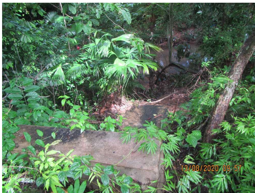
Foto 4. En la ribera izquierda se observó un cabezal, donde la tubería de drenaje pluvial descarga hacia el río Tapia. Fuente: JACUM, Agosto de 2020.
