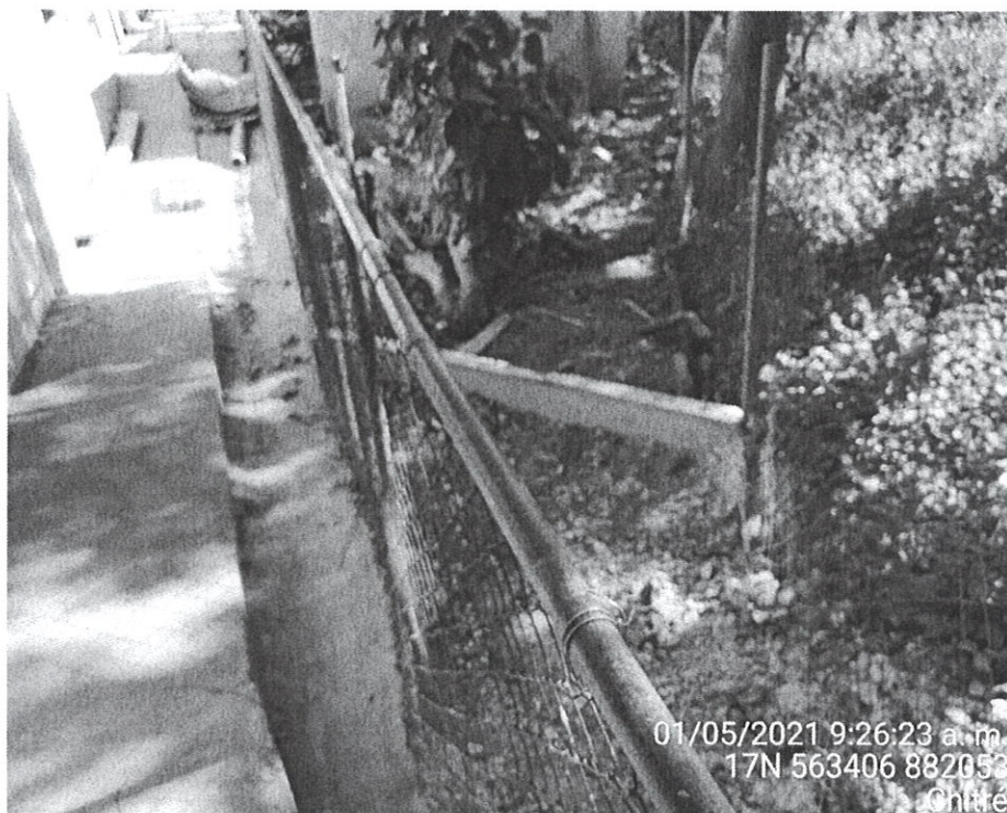
Fig. N° 3 se observa construcción de muro en terreno colindante, según se nos indicó el mismo tiene la finalidad de desviar las aguas del predio colindante hacia la cuneta que está construida en la finca donde se construyó la edificación, esto con el fin de canalizar aguas de escorrentía de predios colindantes.
