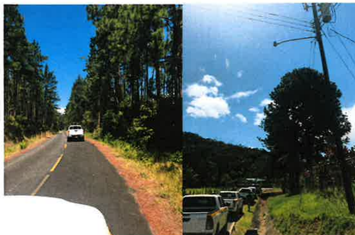
Fig. 1. Parte de la vía contigua a la zona por donde se piensa construir la línea de transmisión Yeguada-Chitrá.
