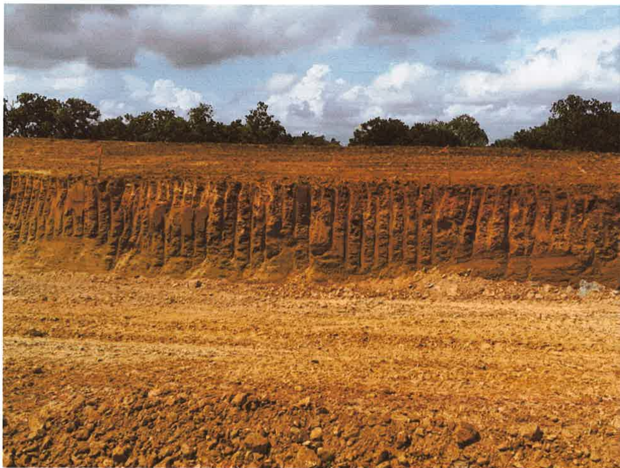
Paquete de arcilla que aflora en la superficie del proyecto
