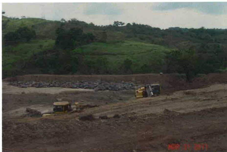
Fotografía 4 Imagen tomada en marzo 2011 en donde se observa movimiento de camiones de equipo pesado debajo de la servidumbre eléctrica. Actividad no segura.
