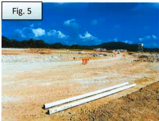
Fig. 5 y 6: Se aprecia los trabajos realizados en el área que fue aprobada en el EsIA, cat. I, para las 74 residencias y el área de servidumbre, donde se ha originado gran sedimentación hacia la vegetación del área del proyecto en evaluación.
