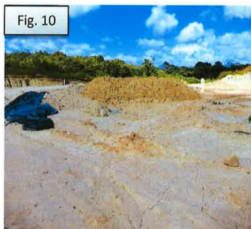
Fig. 9 y 10: Se observa otra de las secciones donde se ubica la servidumbre sanitaria en construcción. Uno de los puntos donde deben realizar un relleno considerado para obtener la altura requerida respecto a las calles a construir.
