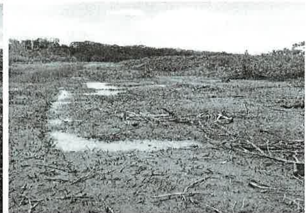
Vista del área en la que el promotor removió materia vegetal (mangle) y sustrato para la habilitación de el canal de desagüe
