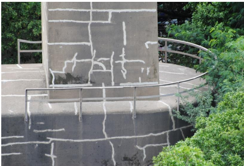
Algunas Pilas presentan señales de reparaciones pasadas.
