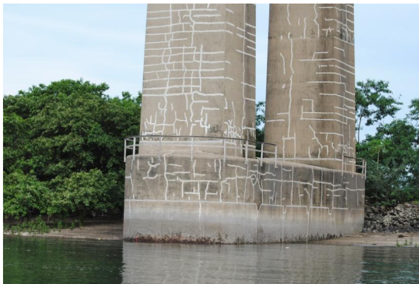
Pilas reparadas en el pasado las cuales presentan señales de haber sido tratadas con inyección epoxica.
