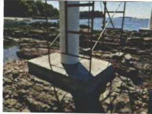
Figura 4. Vista de la losa o base sobre el lecho rocoso.
