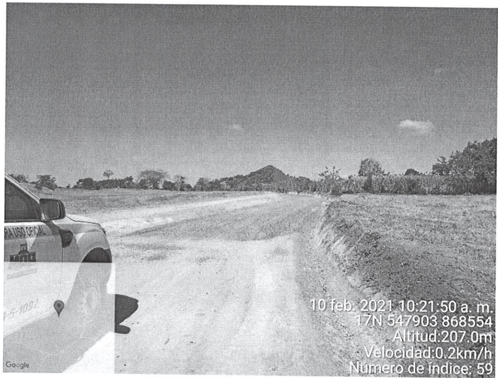
Fig. No. 6: Se observa que en parte del proyecto carretero, ya se ha realizado la ampliación de la calzada, con el ancho requerido, se observó la colocación de capa base.
