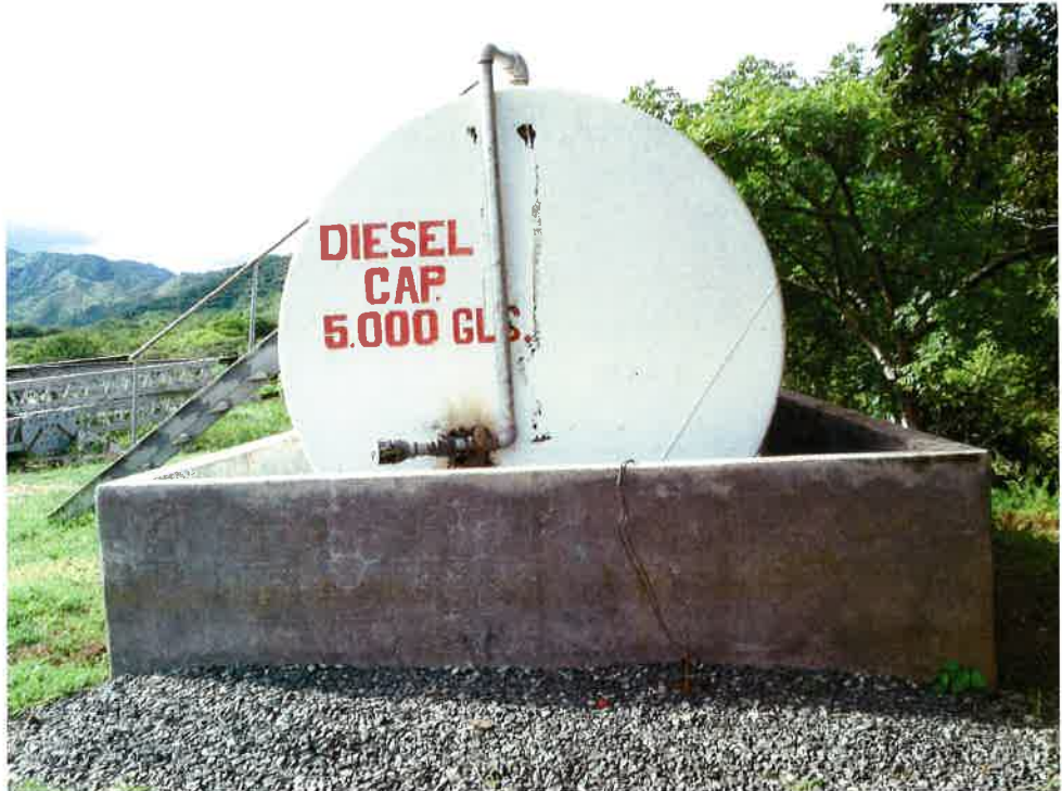
Depósito de combustible con su noria de retención en caso de derrame
