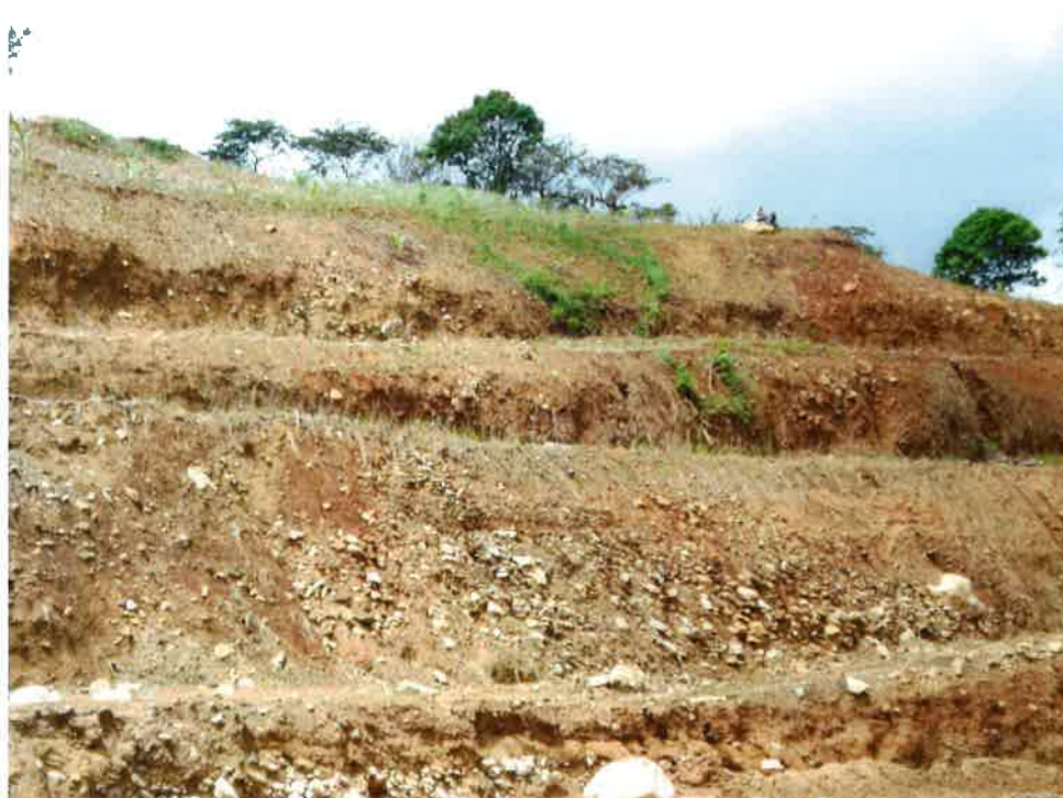
Construcción de "banquetas" en los taludes y siembra de gramíneas
