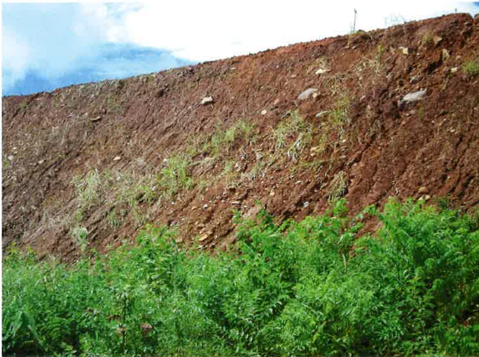
Siembra de gramíneas en los taludes
