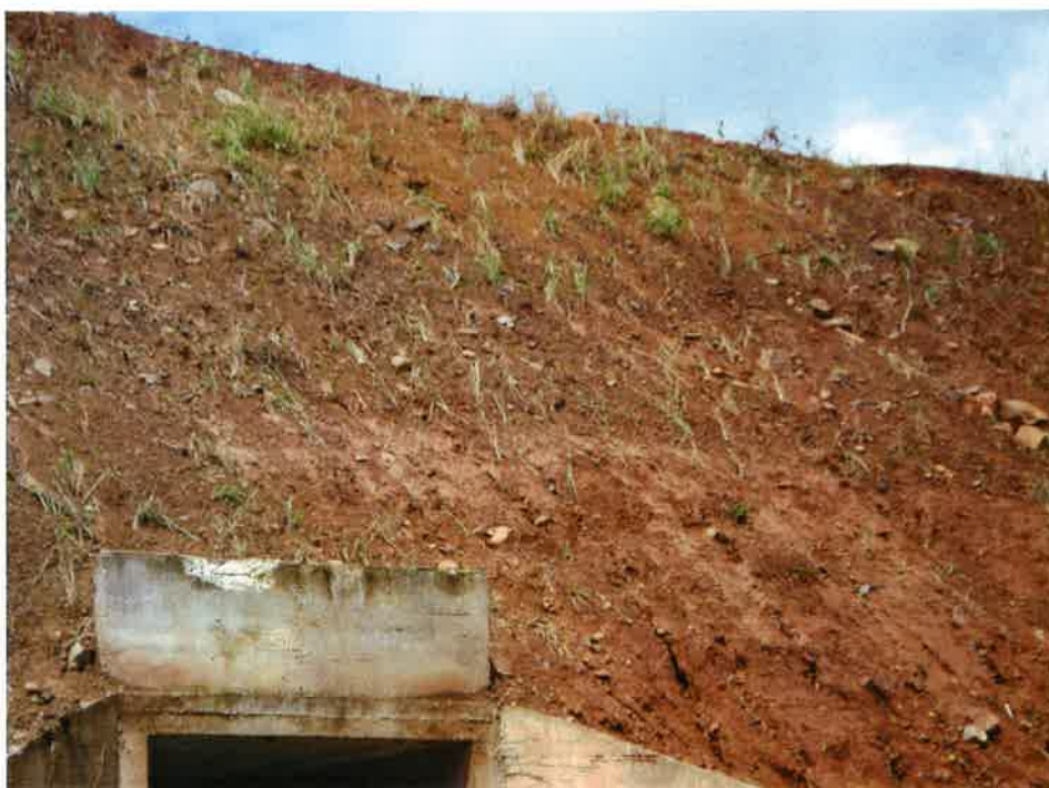
Siembra de gramíneas en los taludes
