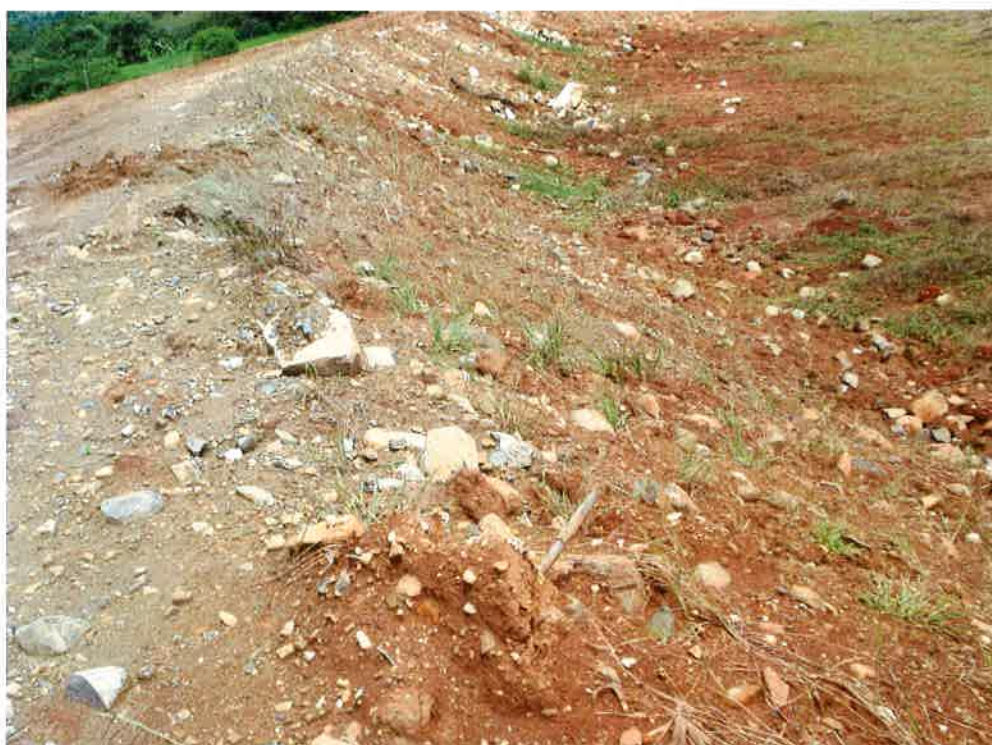
Siembra de gramíneas en los taludes
