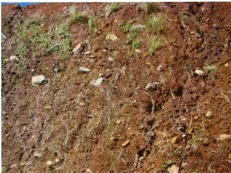
Siembra de gramíneas en los taludes
