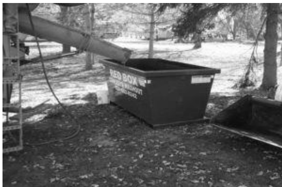
Figura N°13: Ejemplo de tinas de lavado de concreto portátiles
