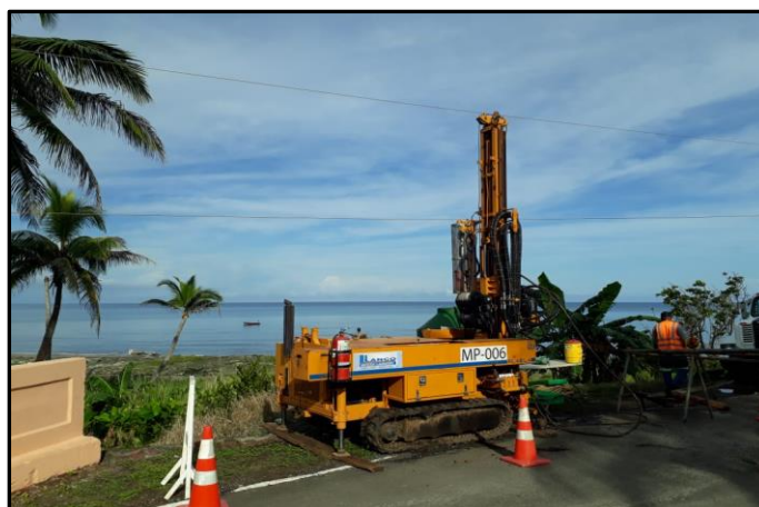
Figura 5. Equipo de perforación utilizado en la ejecución de los sondeos-Puente Salud
