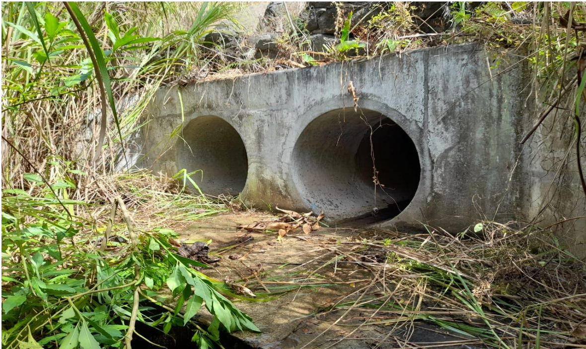
ENTUBAMIENTO EXISTENTE DE LA QUEBRADA SIN NOMBRE VIA PEDREGAL - GONZALILLO
