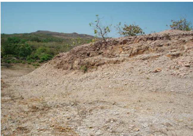
Foto No. 5: Frente de extracción existente de tosca, donde se iniciará la extracción de tosca para la rehabilitación de la carretera. En las capas inferiores del yacimiento se encuentra la piedra.
