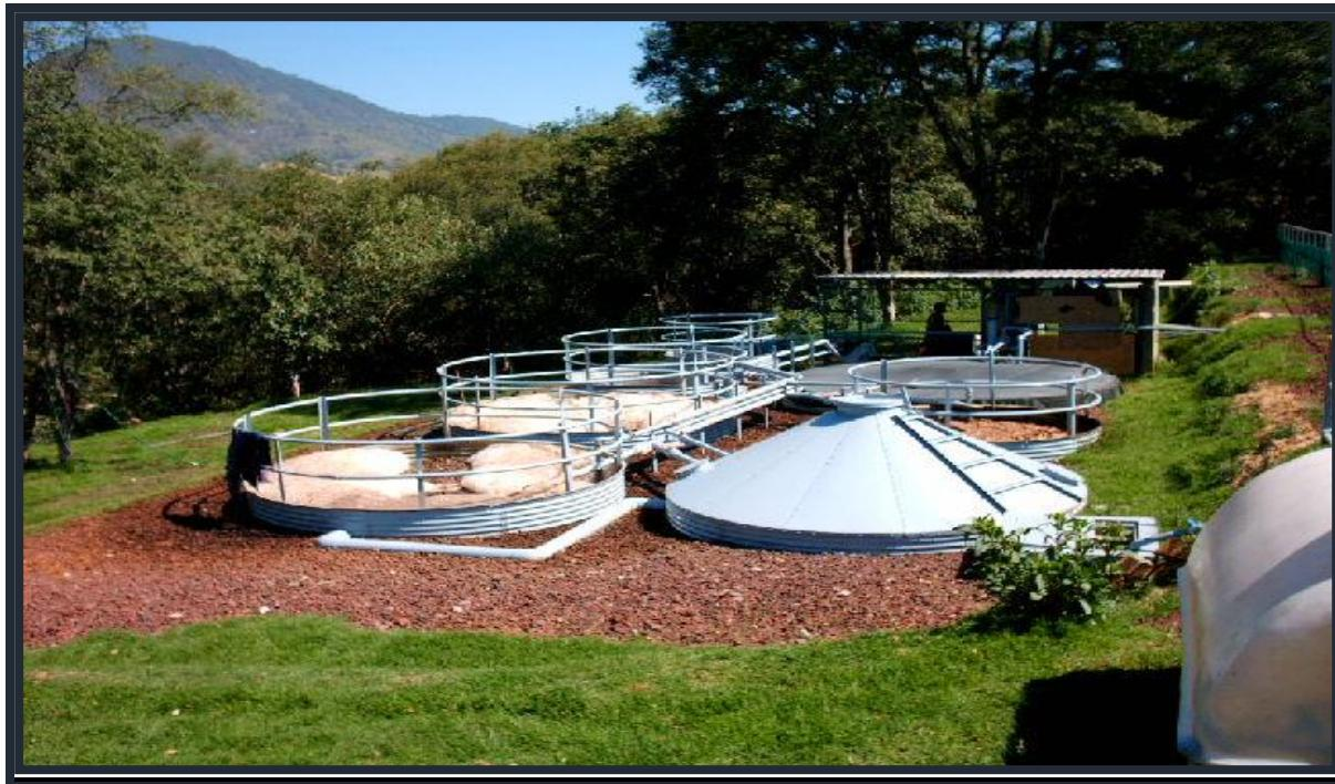
**Figura N° 3. Planta de Tratamiento de Agua Residuales Enterrada**
