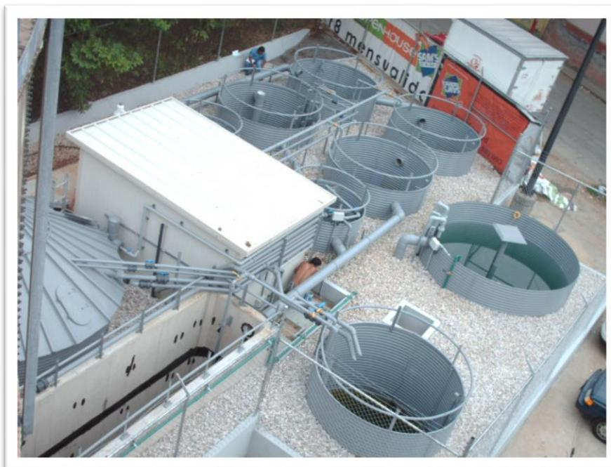
**Figura N° 1. Planta de Tratamiento de Agua Residuales Semi-Enterrada**
