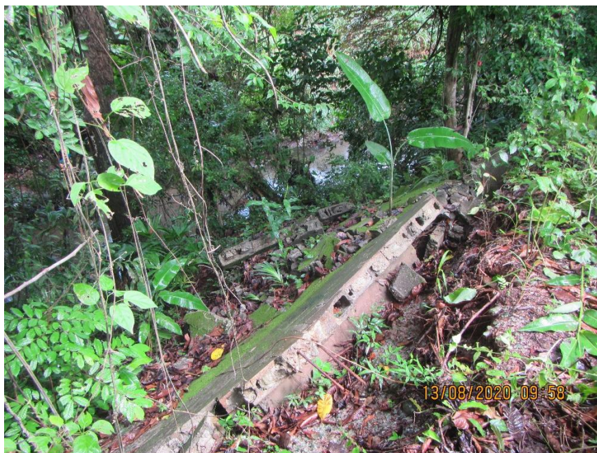
Foto 6. Caída de Muro Perimetral en borde de talud en río Tapia. Fuente: JACUM, agosto de 2020.
