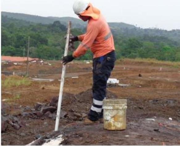
Medición de altura de explosivo cargado en el pozos
