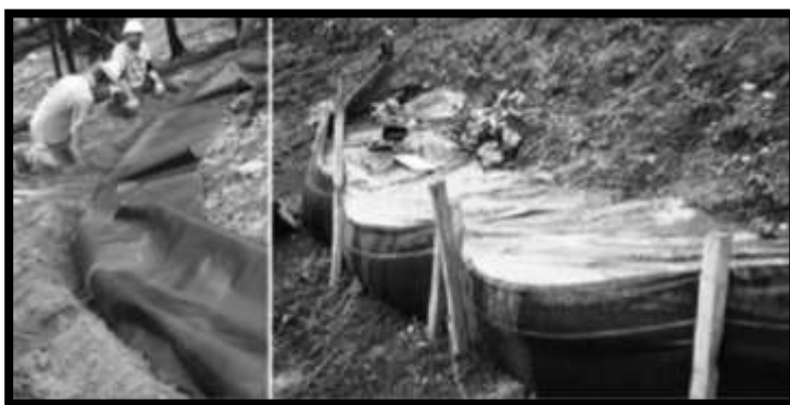
Figura 13. Colocación de mallas de limo hechas de material geotextil.
