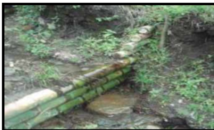
Figura 12. Trincho vivo en la retención de sedimentos.
